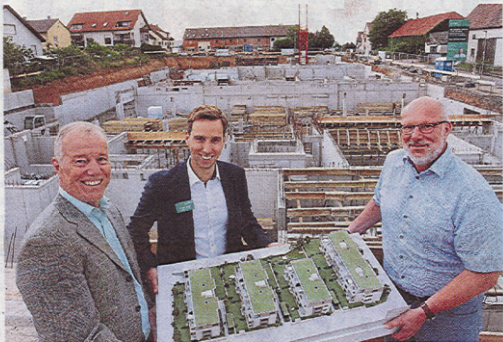
Sie halten das Modell der Wohnanlage in den Händen, im Hintergrund ist die Baustelle zu sehen (von links): Projektleiter Manfred Hertner, Geschäftsführer Philipp Layher und Bürgermeister Rainer Schäufler.
